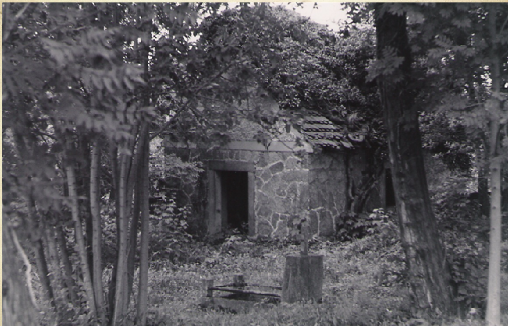
Kaplica na cmentarzu w Płoszczynie – przed remontem
